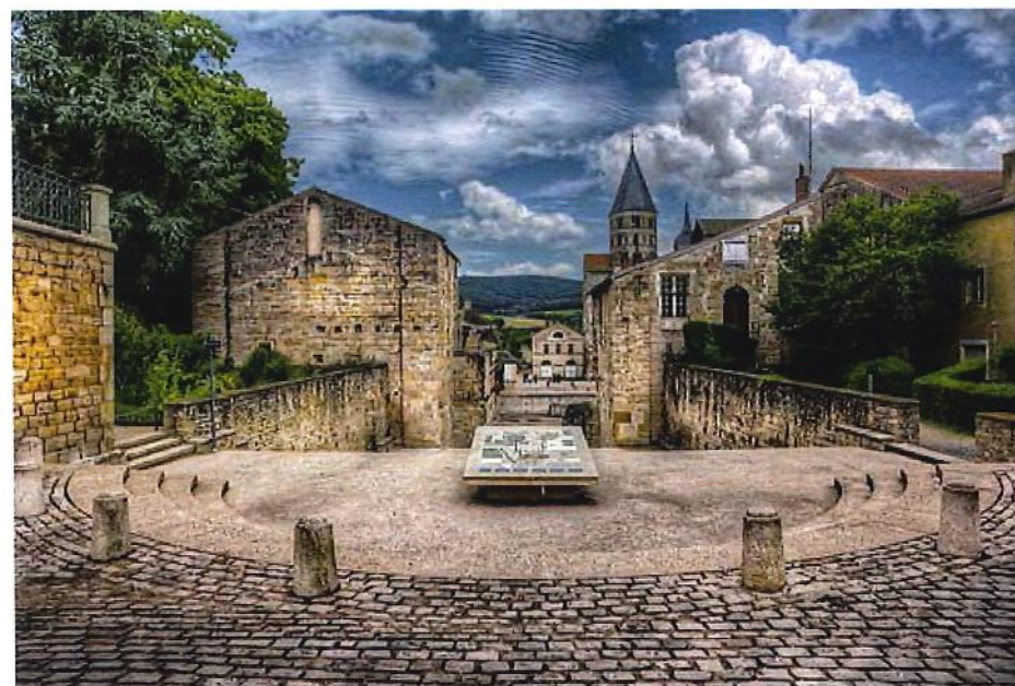
Dettaglio del percorso museale
